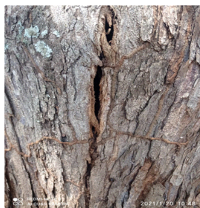
Rachadura no tronco, formada devido a cupins e a larva de besouro com dimensão de 30cm no interior do tronco e 1,3cm de largura. O que coloca sua resistência comprometida com a ocorrência de ventos
